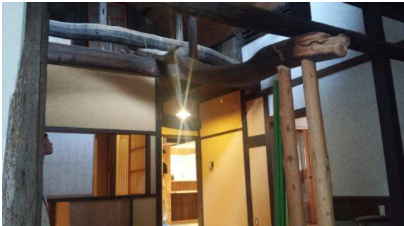
土間の上を飛ぶ曲がり梁
