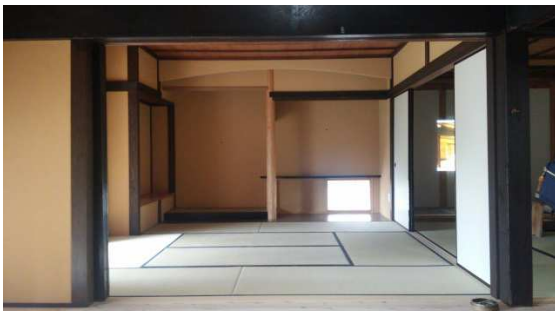
玄関から座敷、床の間を見る
