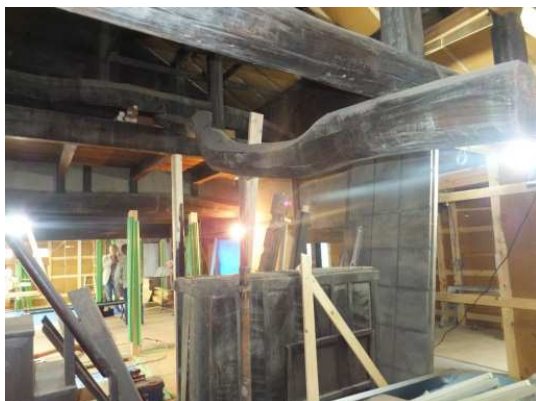
土間の上を飛ぶ曲がり梁
