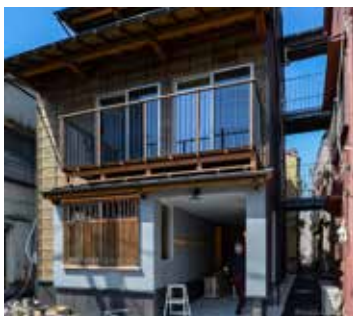
木造耐火共同住宅 [東京都佃島]
